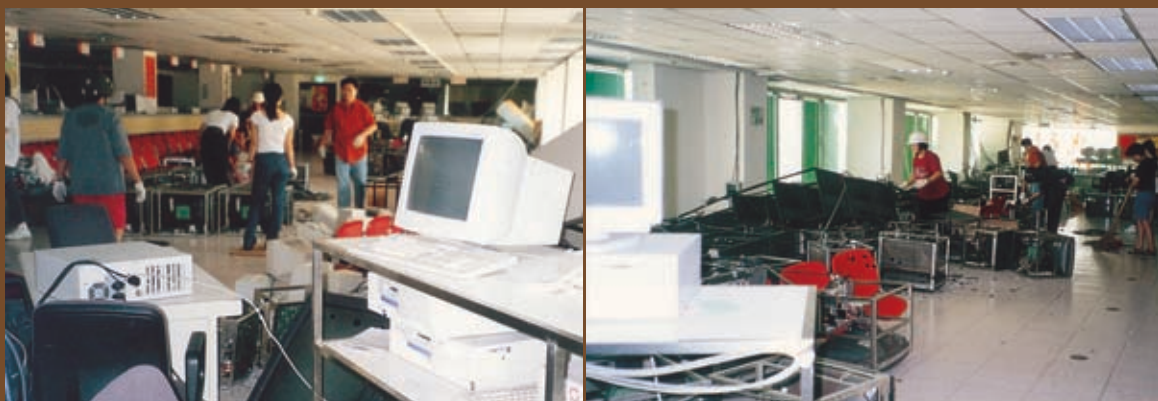
▲88年九二一大地震後南投日茂證券公司營業大廳損毀情形。
